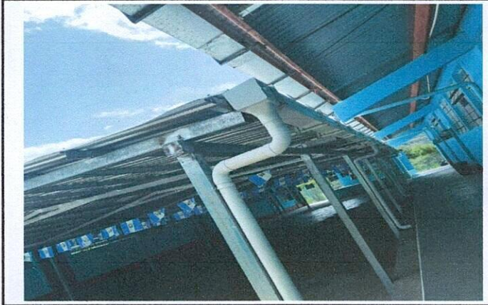
Foto 2: FINALIZACION DE CANALES DE CAIDA DE AGUA.
