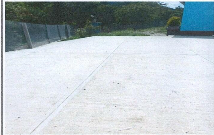
Foto 3: FINALIZACION DE LOZA DE ENTRADA DE PATIO
